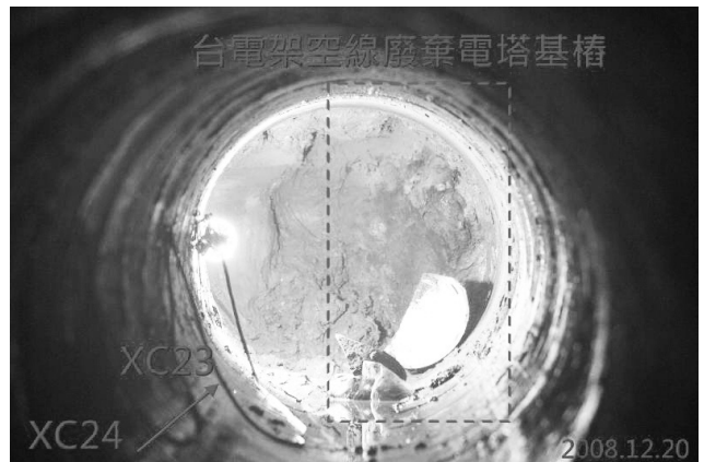
圖二. 原台電高壓鐵塔廢棄基樁
