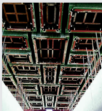
圖5. 現場預鑄新工法，吊裝牆面構件及系統模版
